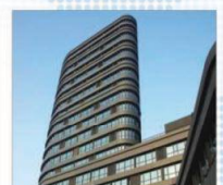
上海新华商务广场 Shanghai Xinhua Business Center 地点(Place): 上海 Shanghai 面积(Area): 22000m² 地板类型(Pave Type): OA网络地板
