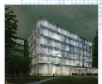
上海诺华制药中心 Shanghai Novartis Pharma Center 地点(Place): 上海 Shanghai 面积(Area): 10000m² 地板类型(Pave Type): OA网络地板
