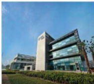
上海数沙制药办公大楼 Shanghai Sandu Office Building 地点(Place): 上海 Shanghai 面积(Area): 20000m² 地板类型(Pave Type): OA网络地板
