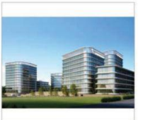
南京润和软件园 Nanjing Meite Software Park 地点(Place): 南京 Nanjing 面积(Area): 15000m² 地板类型(Pave Type): OA网络地板
